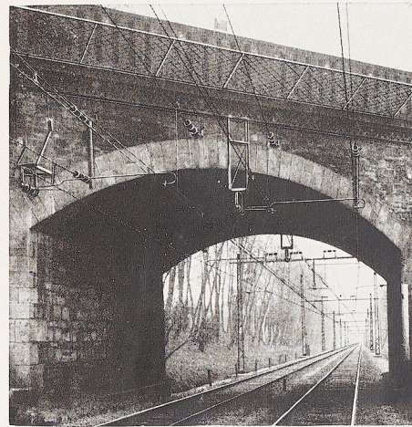
Bild 338. Die Luftschiene: Unterführung der Fahrleitung von Bild 337 unter einer steinernen Straßenbrücke. Geddoppelte Fahrdrähte. Ausgeführt von den Siemens-Schuckertwerken, Siemensstadt bei Berlin.
