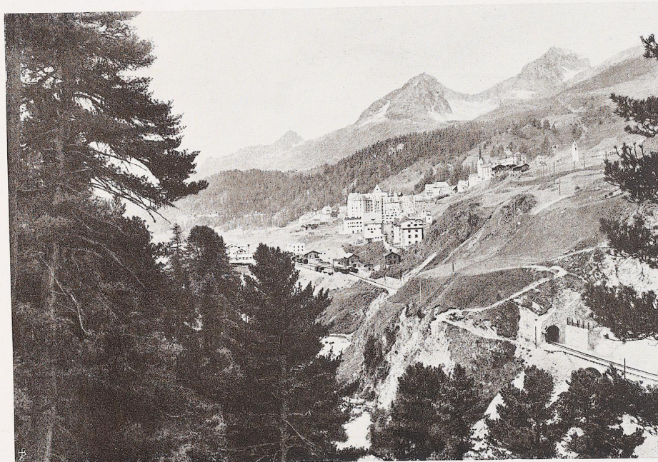
Bild 577. Berninabahn: Nordrampe. Blick über die Charnadüraschlucht auf die Tunnels und Linienführung der Rhätischen Bahn, Strecke St. Moritz-Bevers, und den Gemeinschaftsbahnhof St. Moritz der Rhätischen und Berninabahn. In der Tiefe der Inn mit Elektrizitätswerk; der Innviadukt (Bild 576) ist hinter den Wipfeln der Arven verborgen. Photographie: Berninabahn, Poschiavo.
